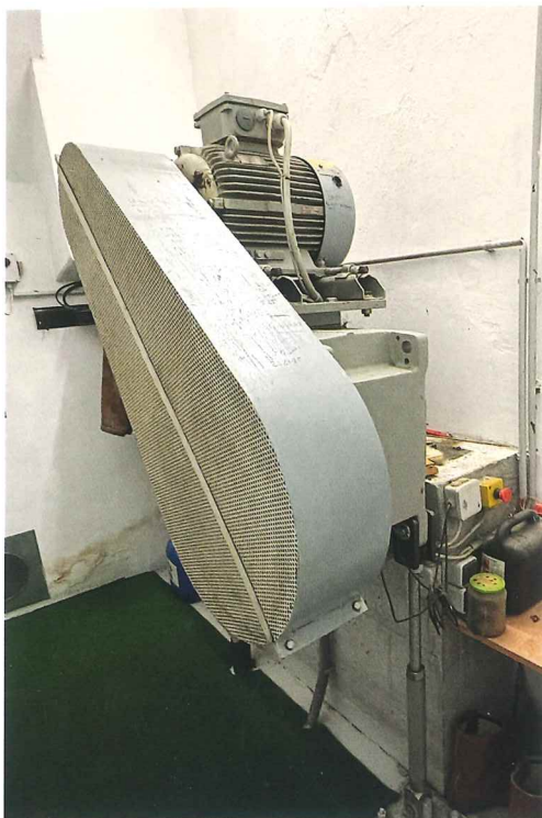
Der wasserradgetriebene Generator der Stiftmühle St. Peter
