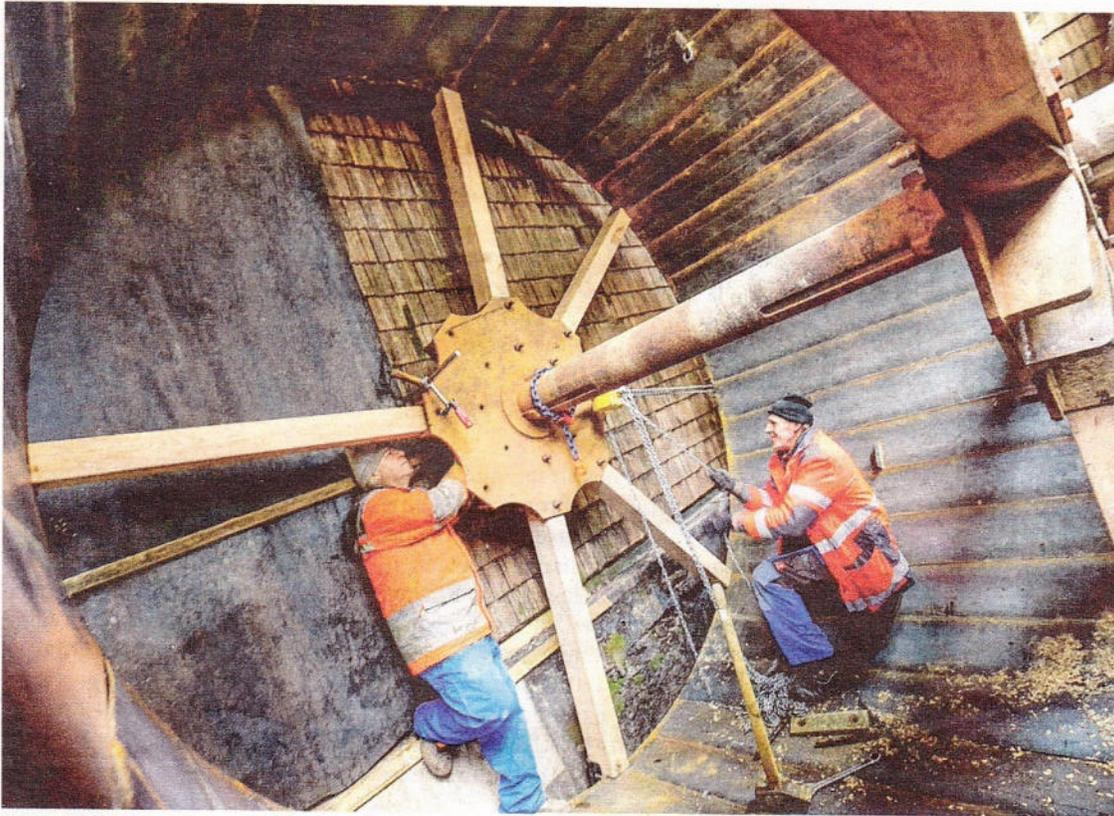
Die Arbeiter der Firma Mühlenbau Neuhofer ersetzen die hölzernen Speichen des Wasserrades. BILD: SN/RATZER
